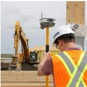
**Applicazioni ingegneristiche:** il GNSS con le precisioni che si ottengono dalle reti trova applicazione nei cantieri delle opere pubbliche, sia per le misurazioni di tracciamento dell'opera, sia per la movimentazione automatica dei mezzi.
